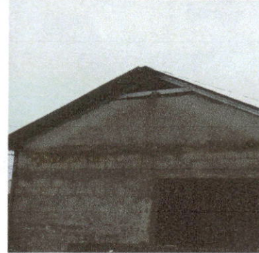
FOTO 2: Reparacion muro de block (culata de cocina)
