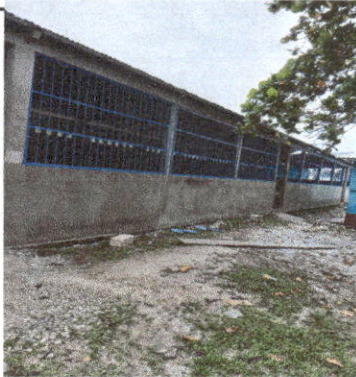
FOTO 3: Fabricacion e instalacion de balcones de hierro en ventanas
