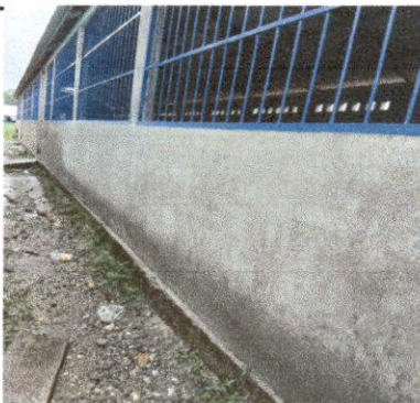
FOTO 5: Repello en muro dentro y fuera de la cocina
