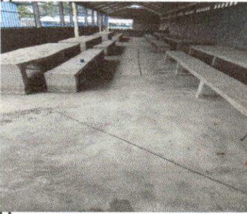
FOTO 1: Sustrucion de piso de cemento líquido
